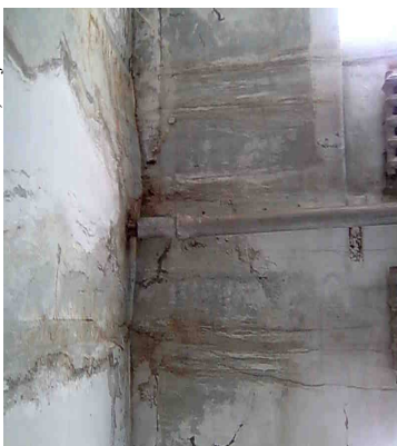
Foto nr. 11: Clădirea CR Basarabeasca, etajul 5
